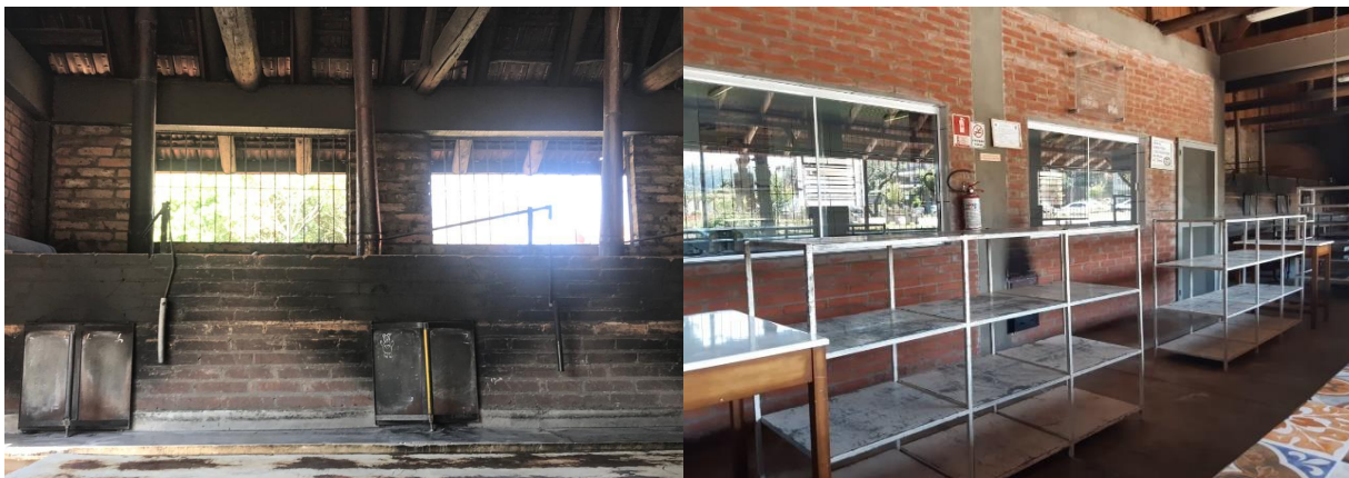
Figura 13 – Estrutura dos fornos de barro e sala de preparação
