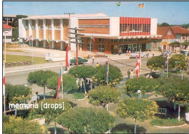
Figura 27 - Vista da Praça Major Nicoletti (Década de 1970)
