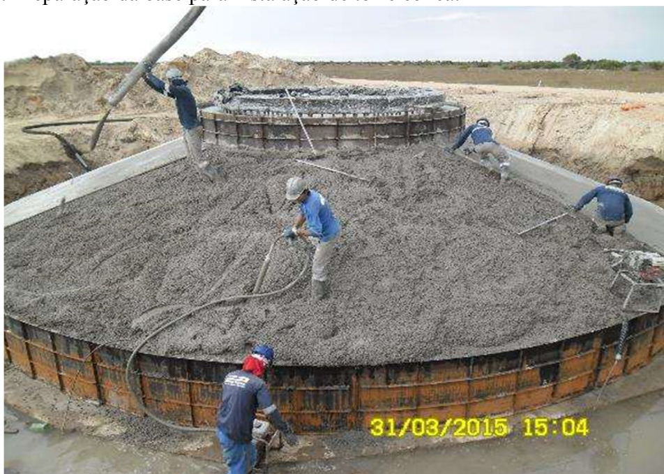
Figura 44: Preparação da base para instalação de torre eólica.
