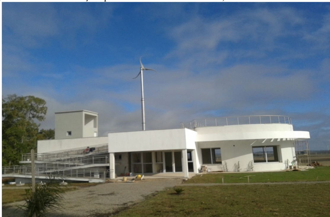
Figura 50: Futuras instalações para atendimento aos visitantes, Santana do Livramento.
