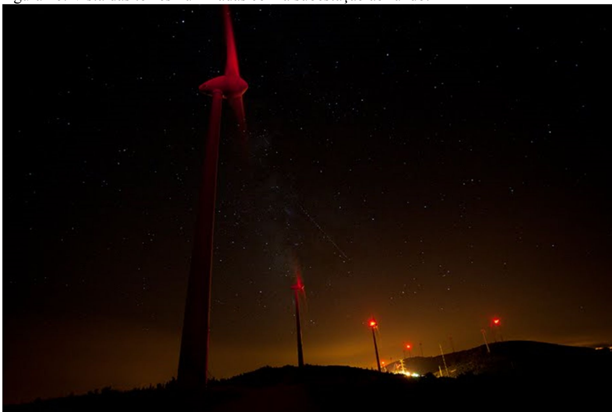
Figura 46: Vista das torres iluminadas com a subestação ao fundo.
