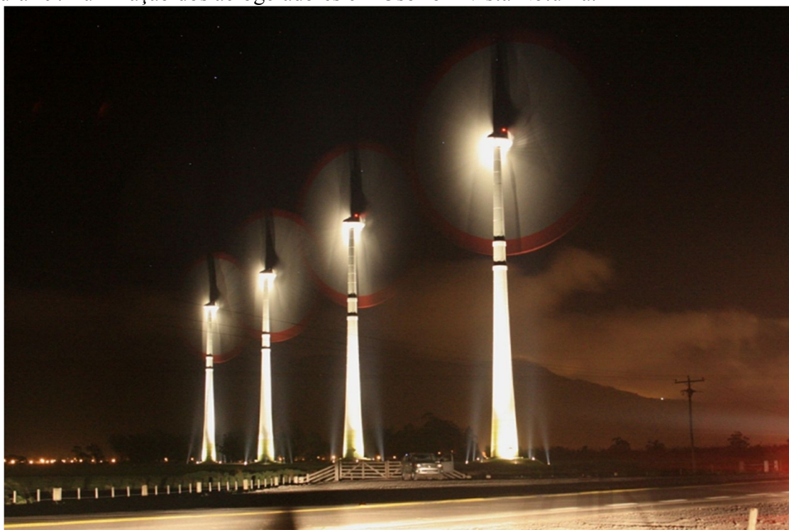
Figura 49: Iluminação dos aerogeradores em Osório – Vista Noturna.
