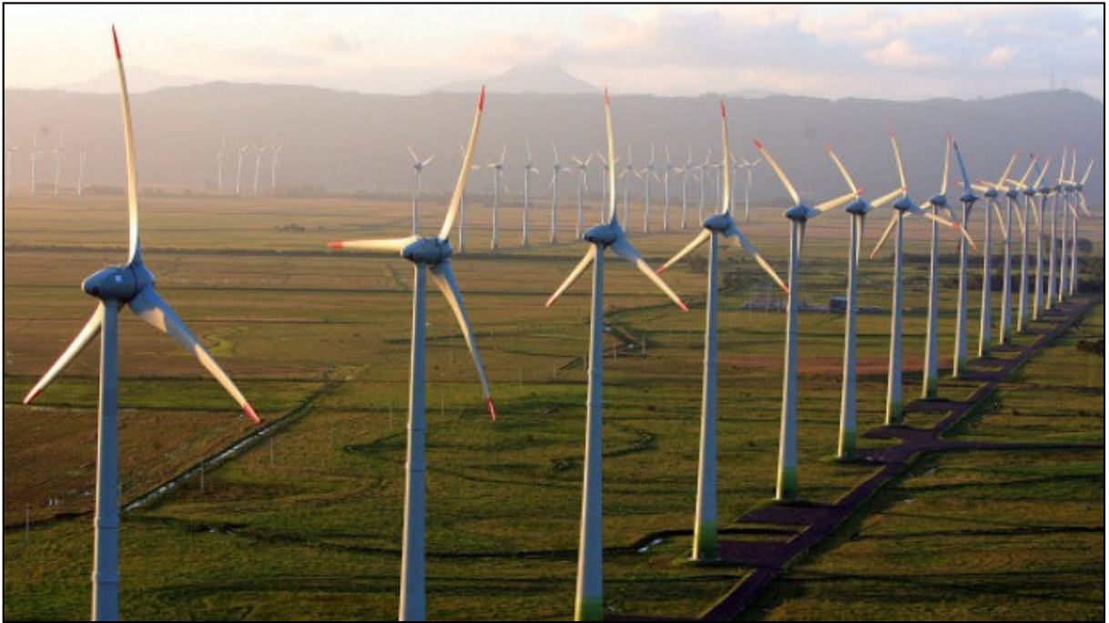
Figura 3 - Aerogeradores no Parque Eólico de Osório.
