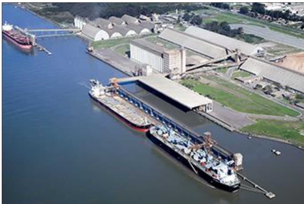
Figura 16 - Terminal CCGL no Porto de Rio Grande
