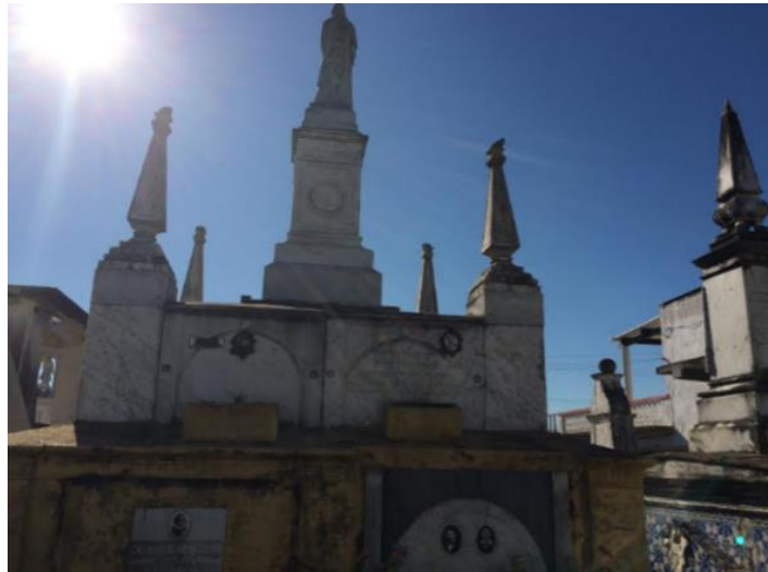
Figura 45 - Revestimento mármore Carrara – I túmulo familiar com 16 gavetas para o enterramento dos pertencentes à família encontra-se na entrada pela rua principal do Cemitério das Irmandades de Jaguarão/RS
