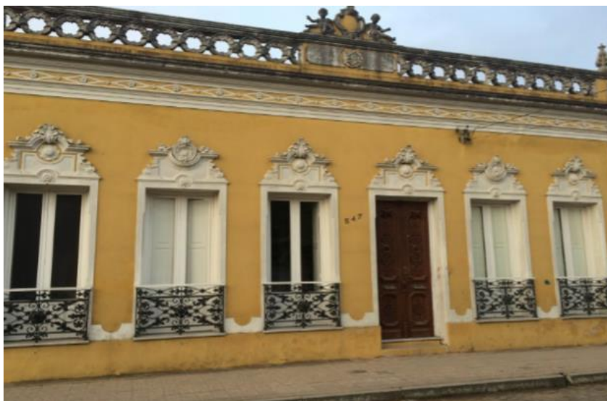
Figura 22 - Fachada Casarão da Rua XV de Novembro em estilo eclético, com a porta em madeira talhada – Jaguarão-RS, 2016
