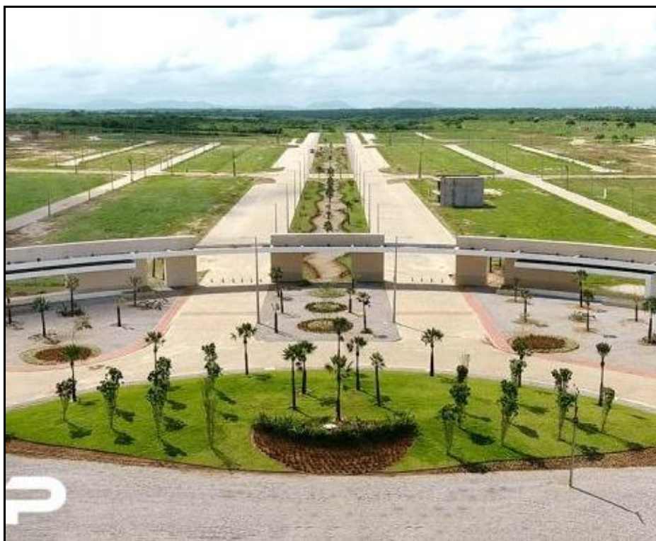
Figura 22 – Obras do Projeto Habitacional Smart City Laguna (Croácia)
