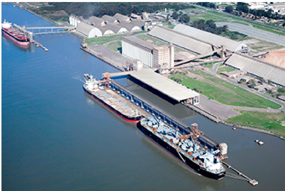
Figura 16 - Terminal CCGL no Porto de Rio Grande
